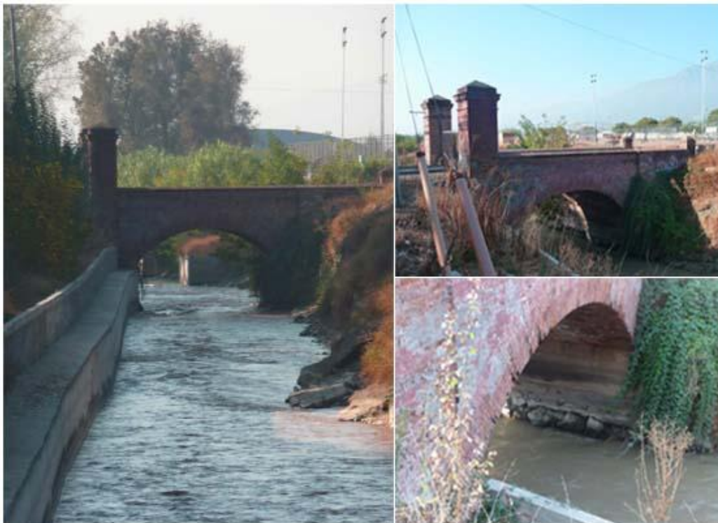
Puente que une los viñedos con el conjunto industrial y el Parque de la Casa Patronal de la Viña Cousiño Macul. Construido hacia 1850, con materiales similares a los utilizados en el Peral, pero con algunas variaciones en el diseño. Fotografía M. Rojas.
