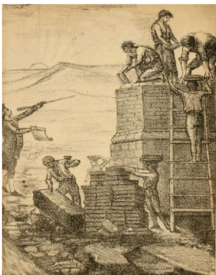
Construcción del puente Cal y Canto.
