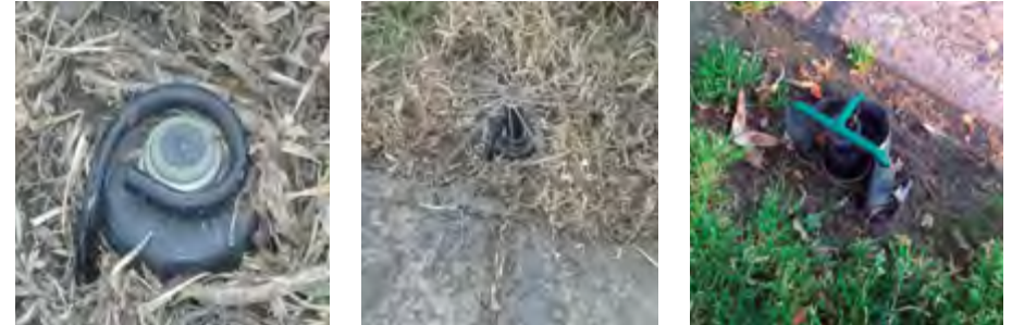
(IZQ. Y CENTRO) REGADOR PROTEGIDO, SIMPLE EFICIENTE Y ECONÓMICO. (DER) REGADOR COMPLICADO, INEFICIENTE, COSTOSO Y PELIGROSO
