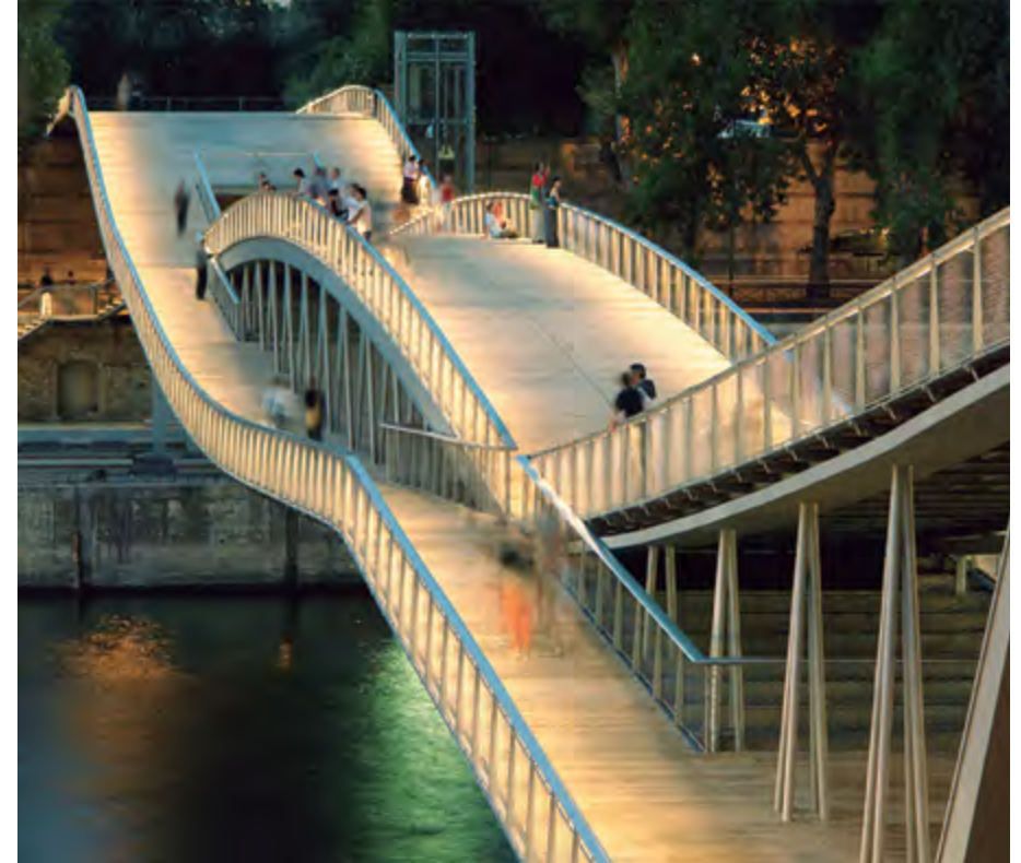
LUMINARIAS EN PASAMANOS PUENTE SIMONE DE BEAUVOIR, PARIS
