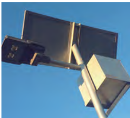
LUMINARIA SOLAR EN PARADEROS DE BUSES, COLINA
