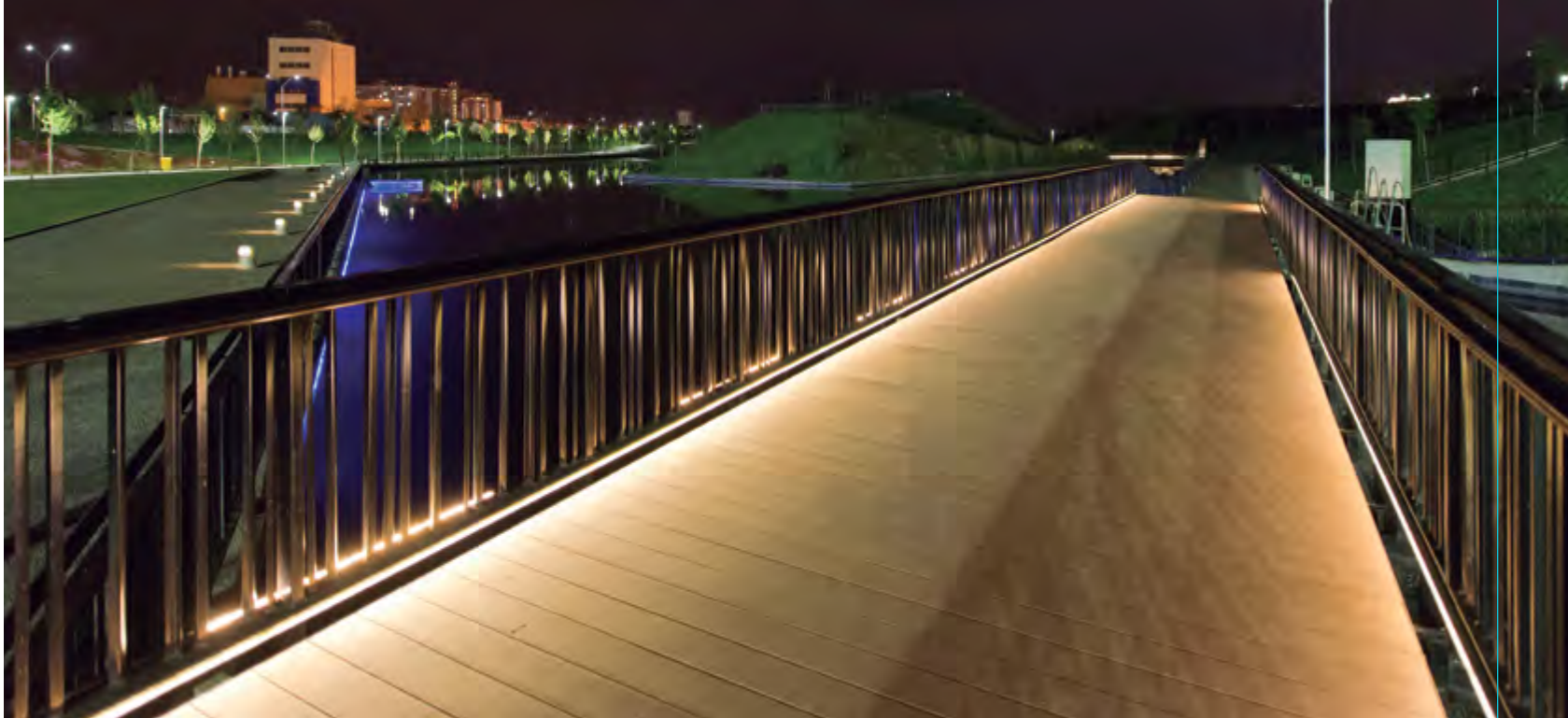
LUMINARIA RASANTE EN PASARELA DE PARQUE RENATO POBLETE, QUINTA NORMAL
