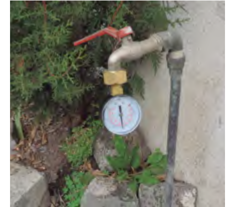
MEDICIÓN DE PRESIÓN CON MANÓMETRO
